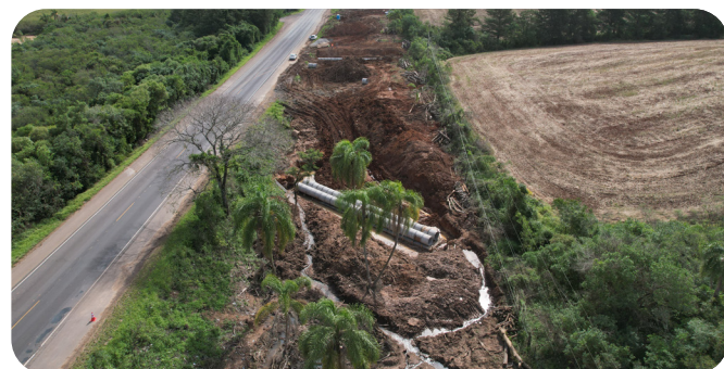
Sistema de drenagem sendo implementado.
