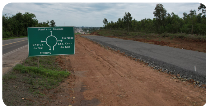
Trecho em processo de terraplenagem.
