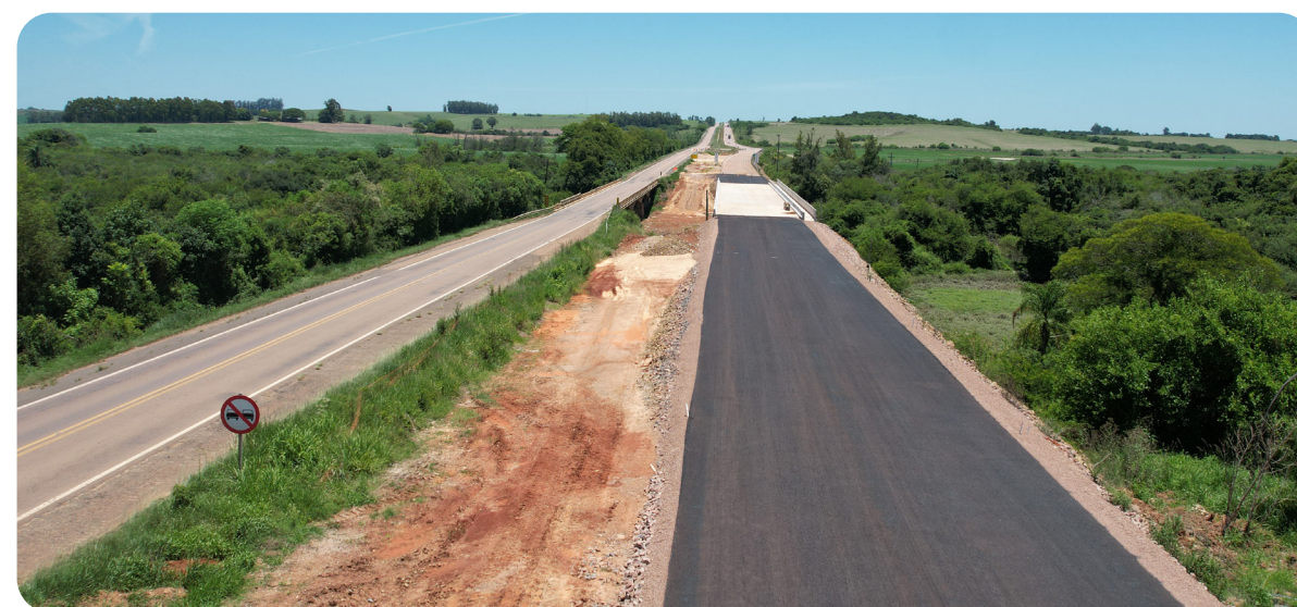
Processo de pavimentação da via no lote 4 (Janeiro/2026)
