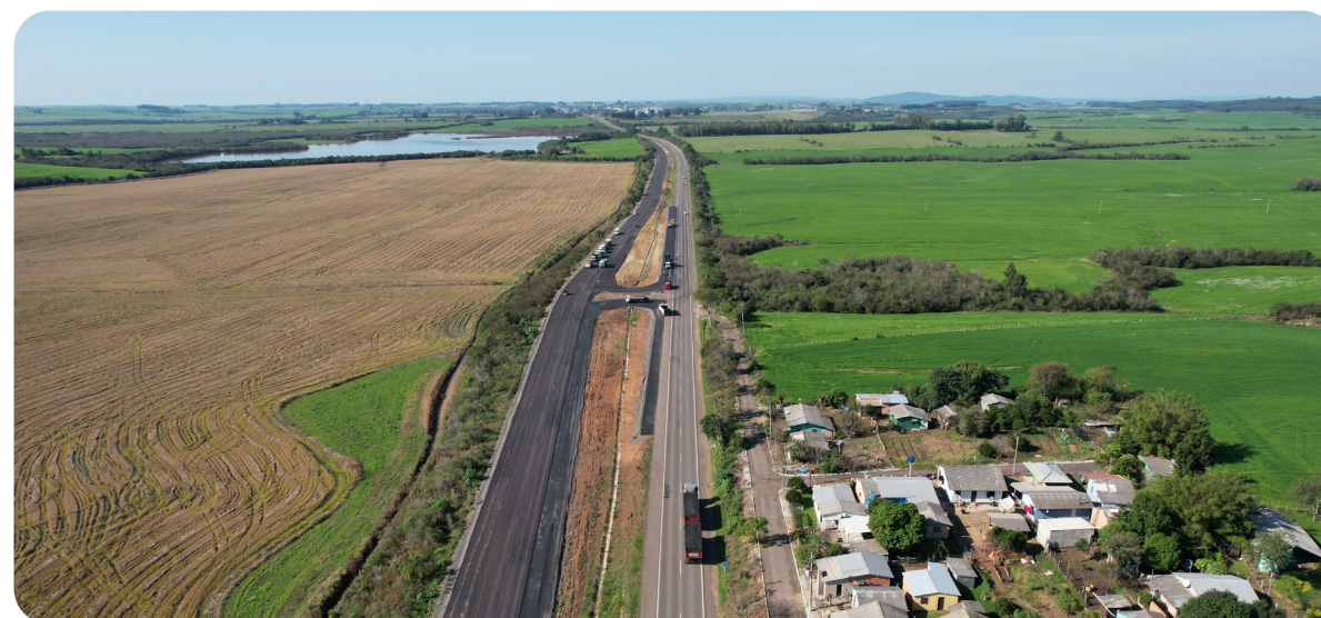
Trecho em pavimentação no Lote 4.
