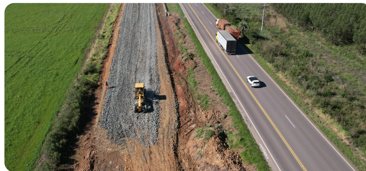
Terraplanagem sendo realizada no Lote 3.
