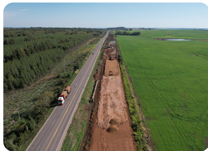
Processo de terraplanagem no Lote 3.
