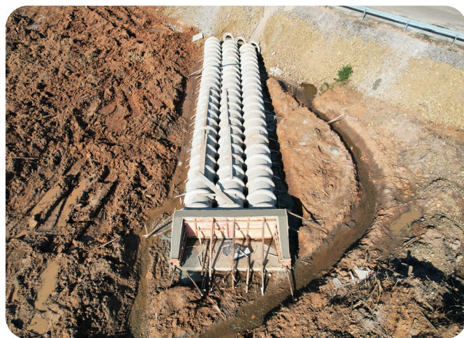
Implantação de drenagem no Lote 4.
